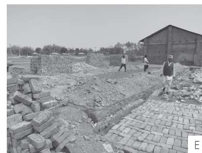
建設が開始されたゴダマラ学校
