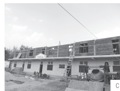
2階増設中のラクスミー学校
