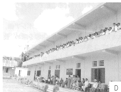
D 2階の増設が完了したラクスマー学校
