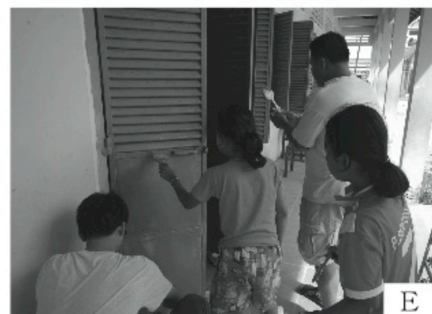
E 校舎のドアと窓の塗装作業
