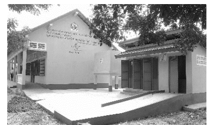
C オンクロン小学校の校舎、トイレ、給水タンク
