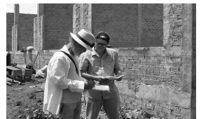
D ボー小学校建設現場にて建設業者と話し合う青野氏
