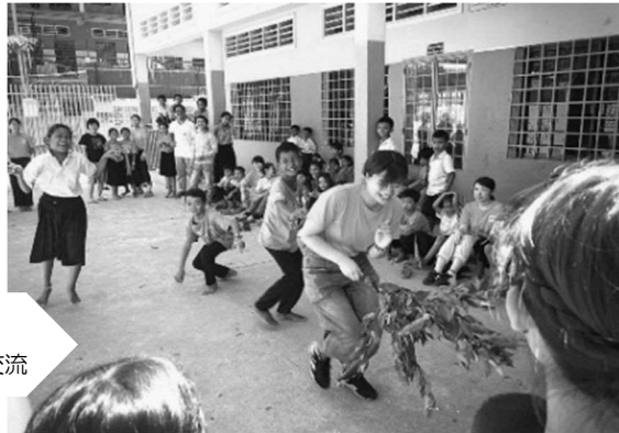
校舎補修 窓枠を外してペンキ塗り
