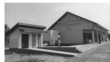
写真C 完成したブレイバオ小学校校舎、トイレ、給水タンク
