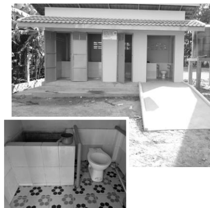
ポー分校 1 棟 2 室トイレと室内
