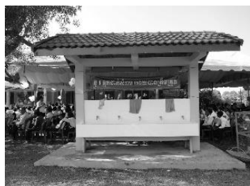
バйдムラン中学校に建設した手洗い場
