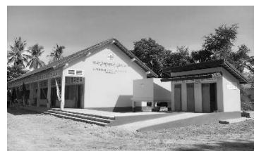
ドントリー小学校新校舎 トイレ、給水タンク
