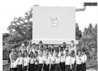
新設された給水タンク(10 m 3 )
