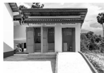
新設されたトイレ タナック中学校
