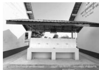
新設された手洗い場 オンクローン小学校
