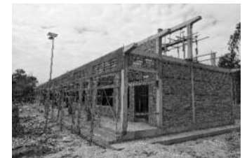
ポチバラ小学校 建設中
