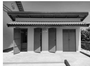
ポーロンク小学校 - 4 室トイレ
