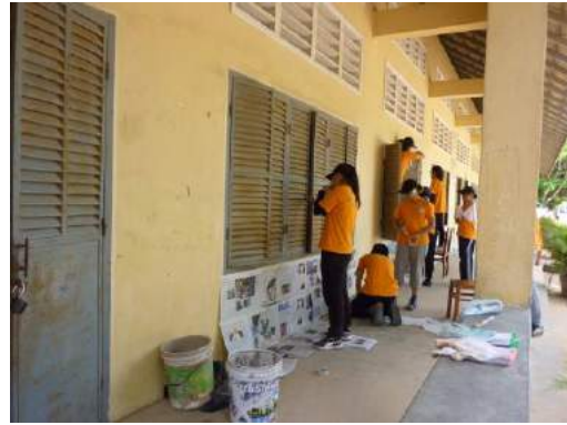
(校舎窓の汚れを落とし、ペンキ塗りをしました)
