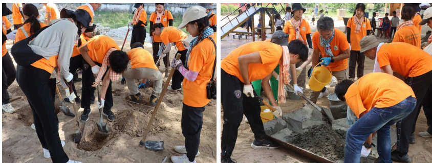
写真) ブランコを設置するための穴掘りとセメントづくり
