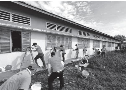
ブラサトスラケオ小学校 校舎外壁を再塗装する支援者
