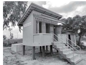
アンルントリア中学校 (左写真) 洪水多発エリアに設置された高床式トイレ3室 (中写真) 贈呈式の様子
