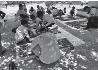
イヤーバアウ小学校 校舎の窓を再塗装する支援者
