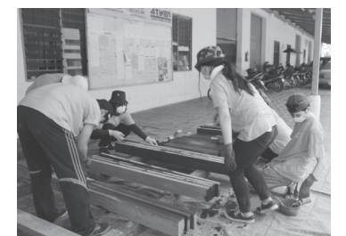
ブランコの部品となる木材に防腐剤を塗装
