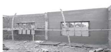
アムリット学校の建設現場内部
