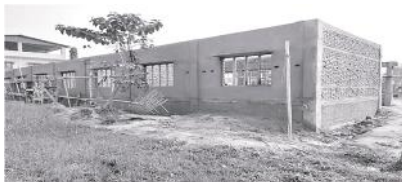
建設中のアムリット学校
